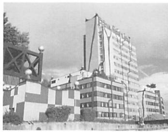
写真4 地域暖房プラントの事務所棟
