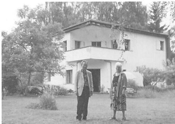
写真5 タウトの旧宅。現在の所有者の婦人画家と筆者。(ここからも建物の損傷がわかる)
