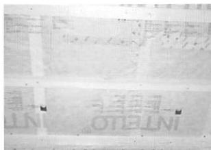
Photo7 相対湿度により水蒸気の透過率が変化するシート
