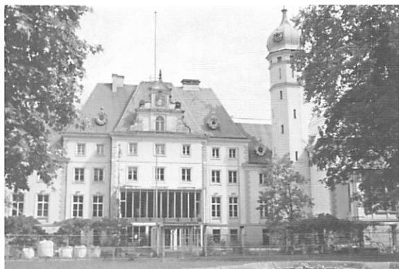
写真14 グリニックの狩の館(Jagdschloß Glinicke)修復工事
