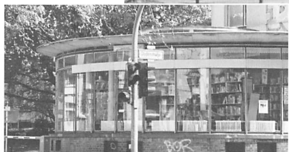
写真12 集合住宅の1階建半円形の突出した部分
