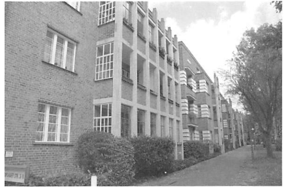
図9 シラー公園の住宅団地、中庭側から見た住宅の一つ
