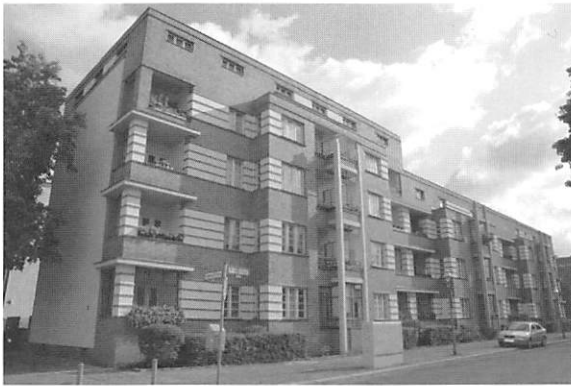
図8 シラー公園の住宅団地、道路から見た住宅の一つ
