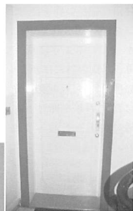
写真10 階段室から各住戸への玄関扉
