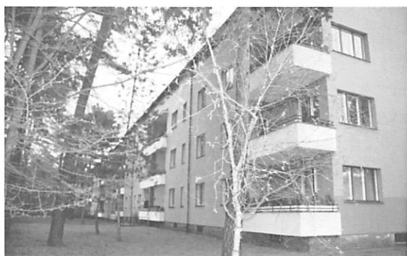
写真6 壁は青色、薄い緑色に着色、窓枠は赤く彩色(アルゼンチン通りの住宅)
