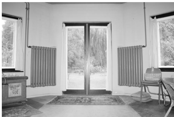
Photo 1 ブルーノ・タウト旧宅に残る重力式暖房の放熱器
