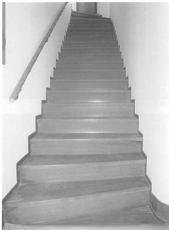
写真1 1階から地下室に降りる階段
