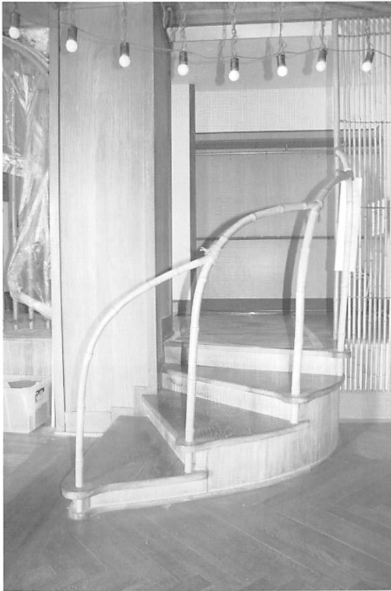
写真2 社交室に降りる真竹を使用した階段
