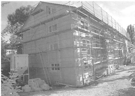
写真 11 外断熱改修工事を行う 1960 年代に建設された集合住宅
