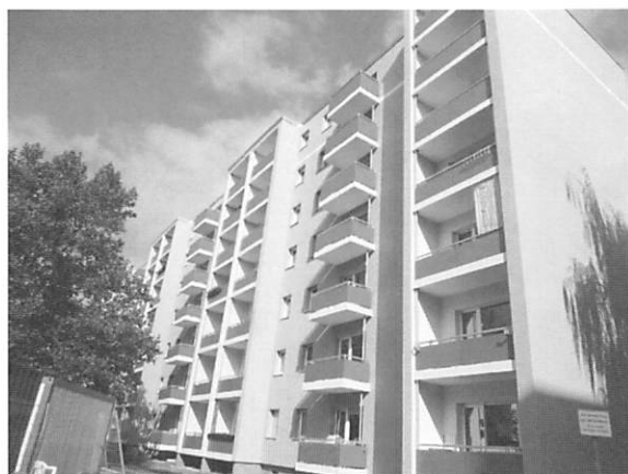
写真6 1986年建設の集合住宅外断熱改修(旧東ベルリン)
