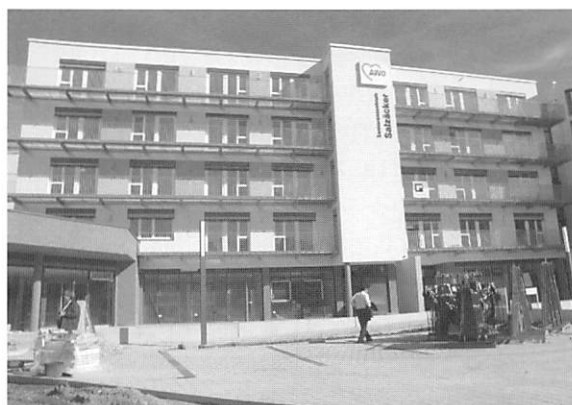
写真10 外断熱施工を行うStuttgartの高齢者施設新築工事
