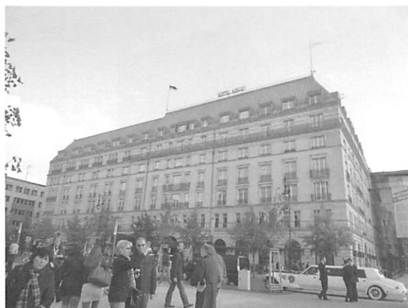
写真7 ベルリンの高級ホテル「アドロン・ケンピンスキー」はXPSで外断熱が施工された。
