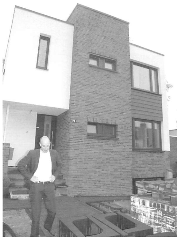
写真4 オランダで完成したパッシブハウス(レンガ張り外断熱XPS使用)
