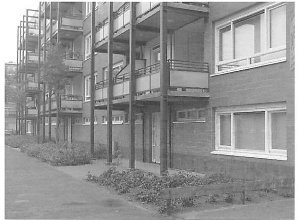
写真3 オランダのタイル張り外断熱集合住宅(XPS使用)
