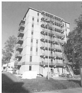
写真18 建設中の木造8階建て集合住宅
