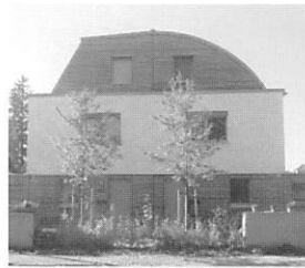
写真19 木質繊維断熱板で外断熱を施工した住宅
