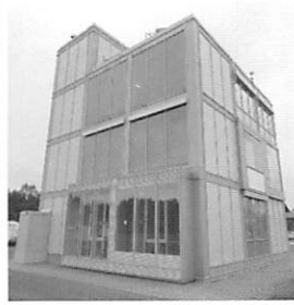
写真16 オフィスビル実験棟
