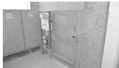
写真12 木造住宅建設現場におけるOSBの使用
