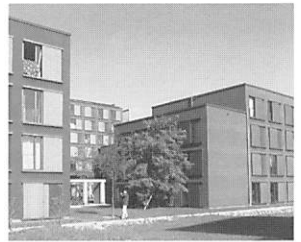
写真21 通気層のある外断熱を施工した学生寮
