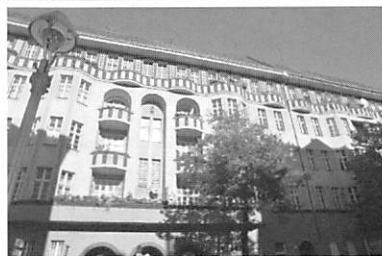
写真32 ベルリン市コトプサーダムの商業建築(タウト設計)
