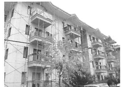
写真8 全面的に押出発泡スチレンで外断熱改修される建物
