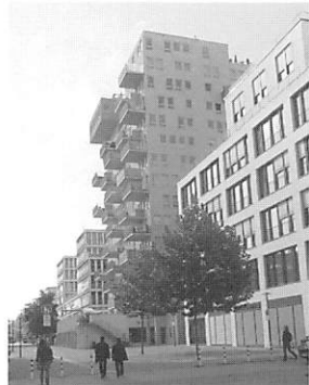
写真20 15階建RC造の集合住宅
