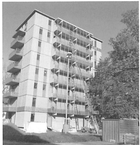
写真5 木造8階建住宅
