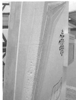
写真16 ガイドラインに基づいて工事された内断熱工法
