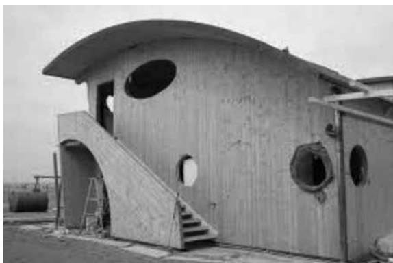
図11 湾曲した BSH (CLT) を屋根に使用した例(窓枠の取り付け部分も工場で切り抜かれ工事現場に搬入されている)
