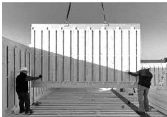
図4 BSHパネルの現場での吊りこみ施工。パネルは工場生産で精度が良い、したがって施工時間が短縮される。
