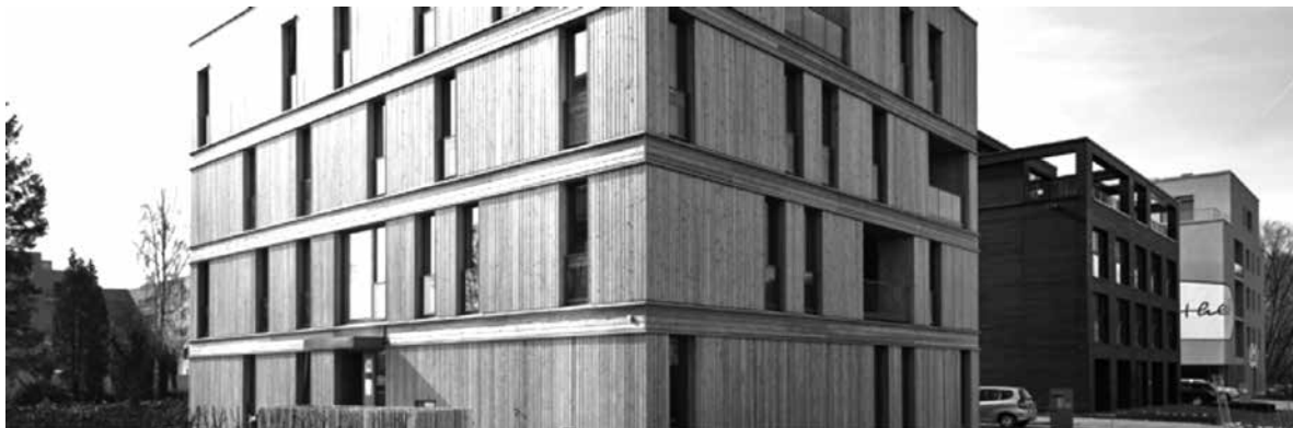
図22 ハンブルグの BSH(CLT)使用事務所建築ケーススタディー(ABA Holz van Kempton GmbH 社)
