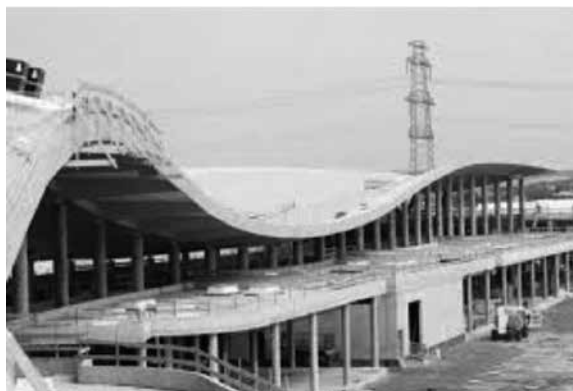
図13 湾曲した BSH (CLT) を屋根に使用する施工現場
