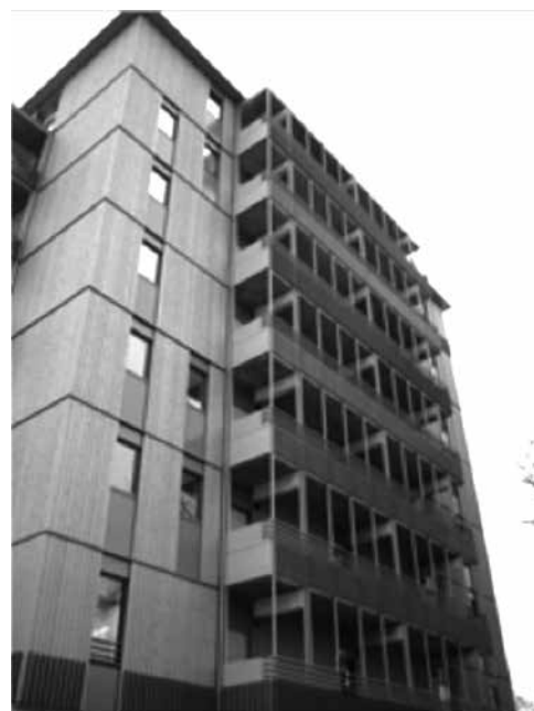
図24 バードアイプリングの竣工後の木造8階建住宅 (BSH (CLT)使用)
