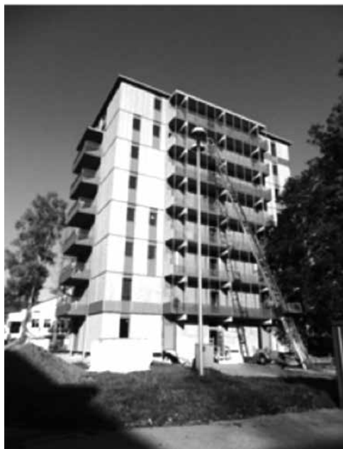
図23 バードアイプリングの工事中の木造8階建住宅 (BSH (CLT)使用)
