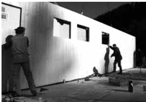
図5 大型外壁パネルの現場組立(精度が高いので施工時間が短縮される)
