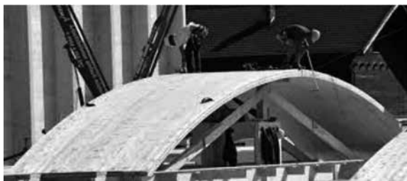
図9 湾曲した BSH (CLT) の施工
