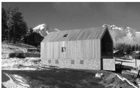
図17 KLH Massivholz GmbHの作品、山岳地帯の木造住宅、Casa Lupe - Vallon Les Loups
