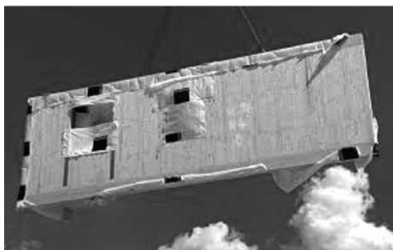
図8 窓枠部分を工場できり抜いたBSH (CLT)パネルのクレーンでの吊りこみ
