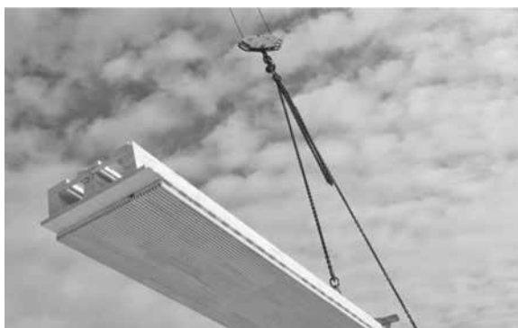
図7 吸音仕上げをしたパネルを接合したBSH (CLT)大型パネルのクレーンでの吊りこみ(Lignotrend Produktions GmbH)
