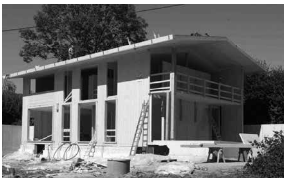
図14 オーストリア、クラゲンフルトで施工中のBSH(CLT)使用木造住宅(KLH Massivholz GmbH)
