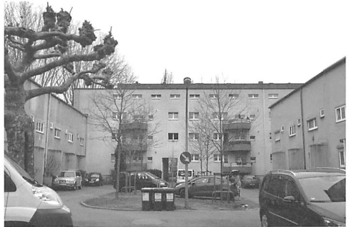
写真9 マール・マルクス通り集合住宅(図6)のアイソメ図に相当部分
