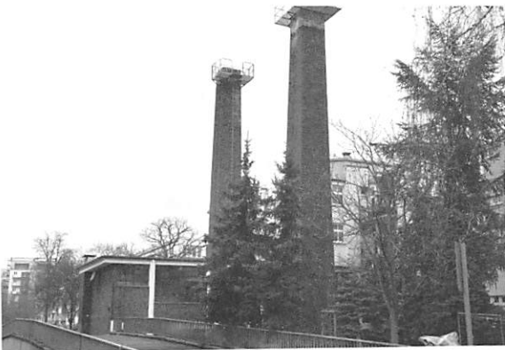
写真12 ヘーラーホーフジードルングの暖房ステーション
