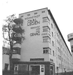
写真24 カール・レギエンの住棟隅角部
