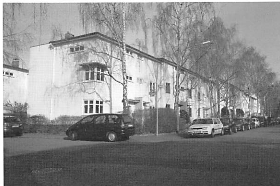
写真6 ヘーエンブリックの集合住宅
