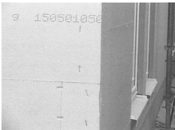
写真1 外壁への木毛繊維断熱板の張り付け、水切りは十分な幅を必要とする
