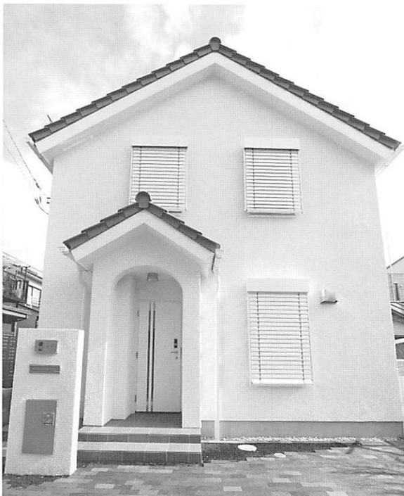
写真5 夏季の日射による室内過熱防止のための外ブラインド
