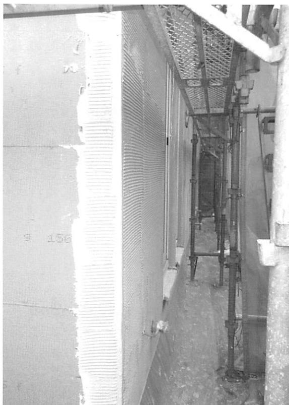
写真2 モルタル層のひび割れ防止の為、耐アルカリ性グラスファイバーメッシュの貼り付け
