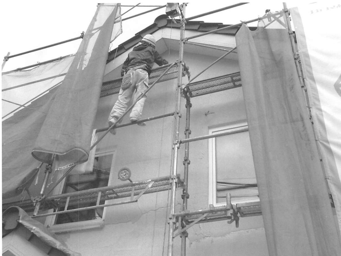
写真3 薄く接着モルタルの上塗り
