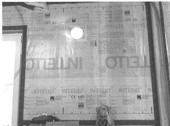
写真4 壁内結露防止のため調湿気密シートの貼り付け文献1)
