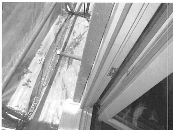
写真6 木製サッシ使用の高气密・高断熱窓の設置
