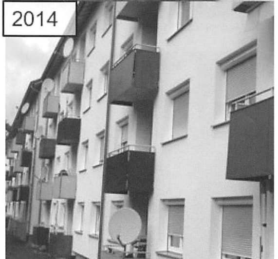
写真6 2004年に竣工し、2014年に改修した集合住宅
