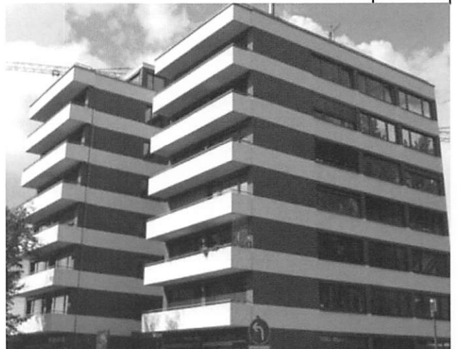
写真7 2008年に既存の湿式外断熱の上にさらに8cmの湿式外断熱を施した例。塗装にはシリケート塗料を使用（ノイマルクト）
