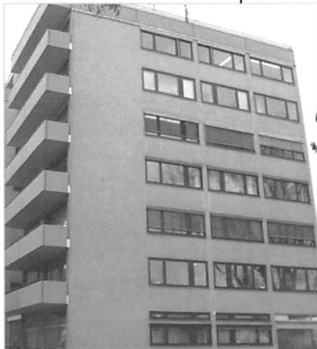
写真7 2008年に既存の湿式外断熱の上にさらに8cmの湿式外断熱を施した例。塗装にはシリケート塗料を使用（ノイマルクト）
