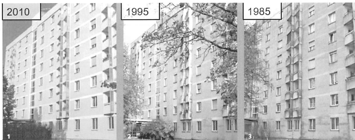
写真3 1985年に建設され、2010年に塗装の改修を行った集合住宅
