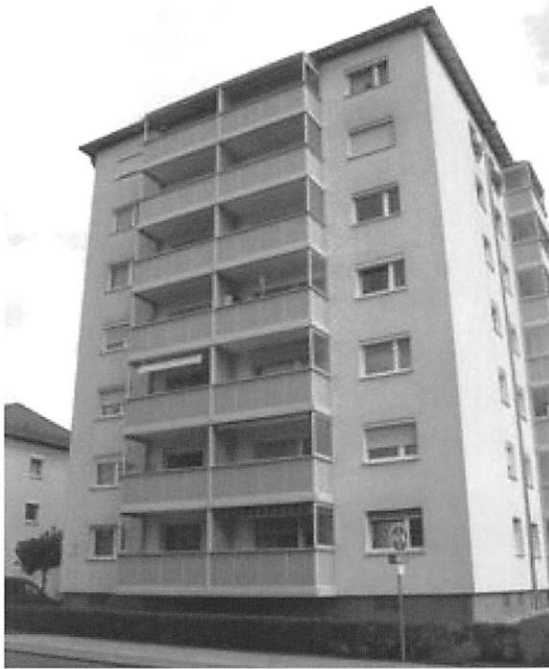
写真4 2008年にバルコニー部分を塗装して改修した竣工後44年経過した集合住宅
