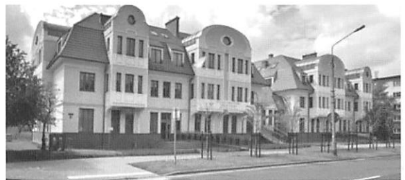
写真10 多彩な形状、多彩な彩色の湿式外断熱が新築、改修に利用されるようになった。
