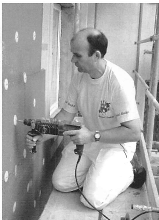
写真2 既存の湿式外断熱の上にさらに湿式外断熱で断熱補強
