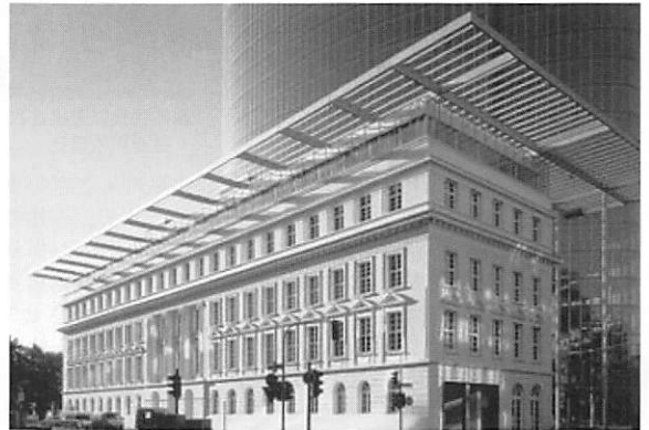
写真15 金属仕上げの湿式外断熱
