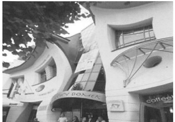
写真9 表面が曲面であり、白色でない外断熱工法も使用されるようになった
