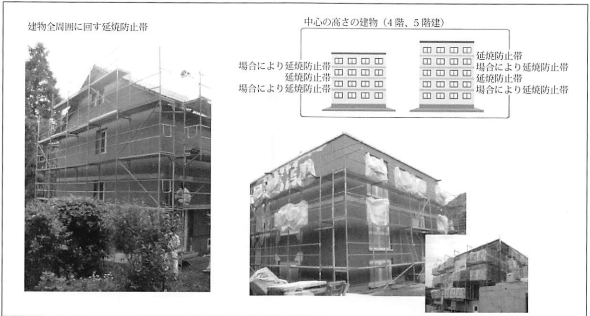
図 14 断熱面での火災の侵入防止
