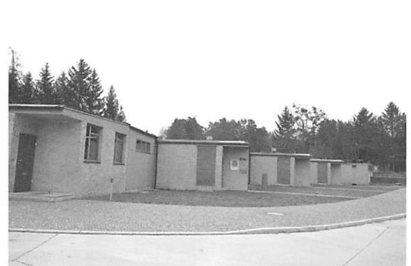
写真 31 6棟の教員宿舎
