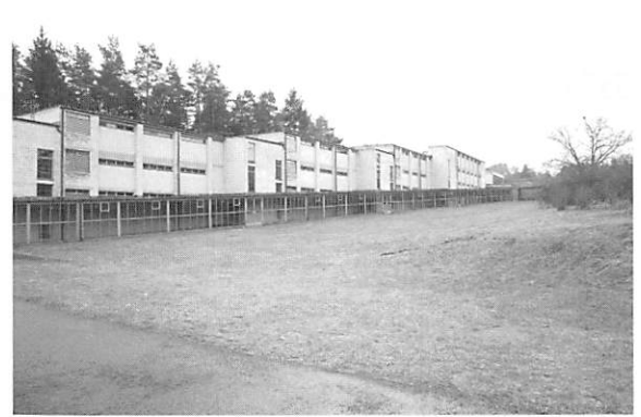
写真 29 傾斜地の建設された校舎
