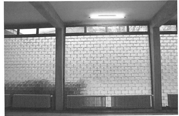
写真16 廊下の外壁に設置されたガラスブロック(上部は透明ガラスを設置し、採光の効率を上げた)
