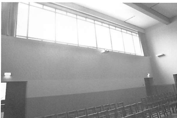
写真8 講堂の外壁窓（高い部分に窓を設け採光の効率を上げた）
