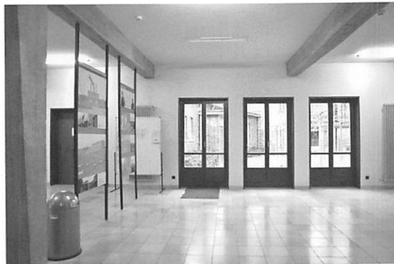
写真15 建物の廊下から中庭の眺め
