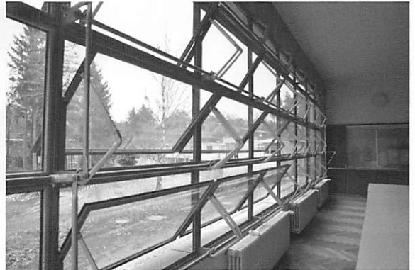
写真20 ガラス窓の自然換気用に設けられた開閉装置(デッサウのパウハウスの建物グロピウス設計)にも同様の装置がある
