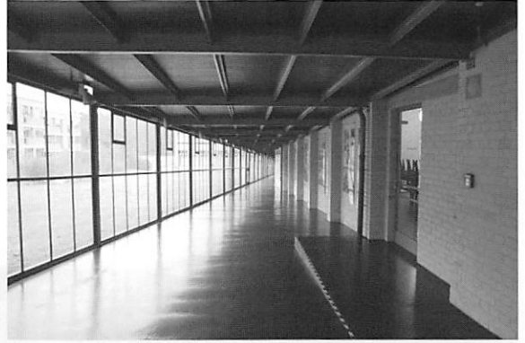
写真18 建物に設置された片廊下(ガラス張りにして廊下を付設温室とした)
