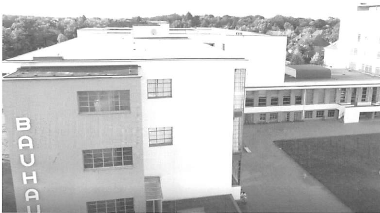
写真4 グロピウス設計のデッサウ校舎
