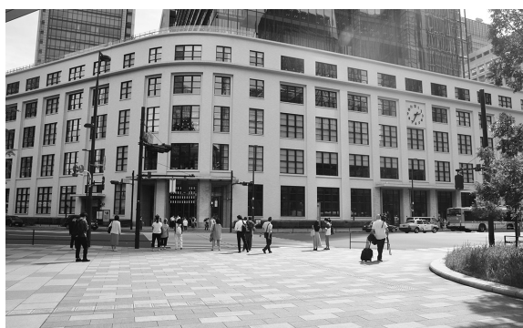
写真4 東京中央郵便局(吉田鐵郎設計)。2009年取り壊されかけたが、当時の総務大臣鳩山邦夫の努力によりファサードは残った。
