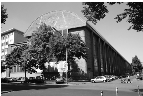
写真5 AEGタービン工場
