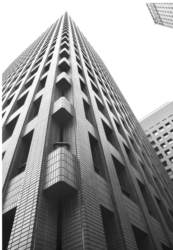
写真3 金属パネルも全面ガラスも使用されていない東京海上ビル
