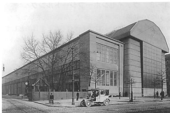
写真 11 ペーター・ペーレンス設計の AEG タービン工場
