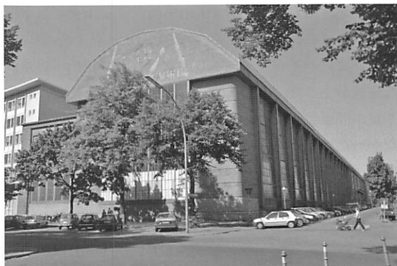
写真 14 現在の AEG タービン工場(現在はジーマス社)
