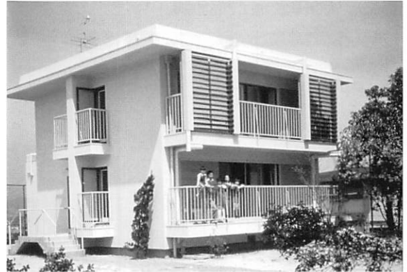
写真1 1977年サンシャイン計画で建設された全面的に湿式外断熱を行った実験住宅
