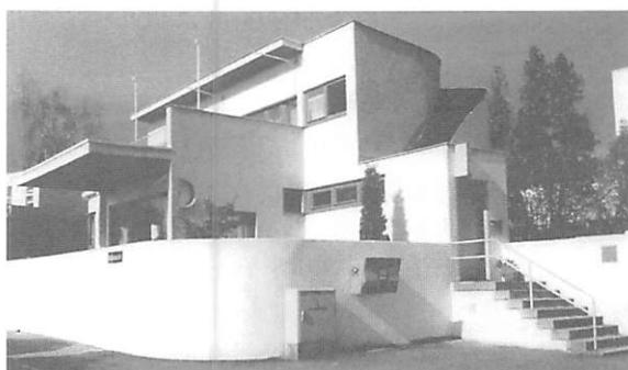
図2 ヴァイセンホーフジードルングの一家族住宅(Weißenhofsiedlung, Hözelweg 1) 設計者：ハンス・シャロウン(Hans Scharoun) 鉄筋コンクリート造断熱パネルを用い外断熱、外側に軽石コンクリート仕上げ、内側に石膏板を左官仕上げ。
