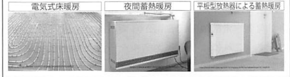
図3 電力による直接暖房
