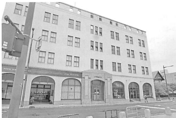
写真3 旧日本郵船ビル
