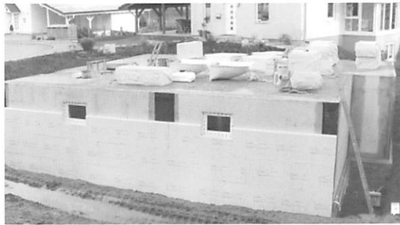
図12 プレハブ住宅地下室外周の断熱
