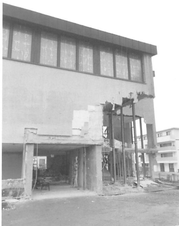
図1 新使徒教会シュルンドルフの解体工事
