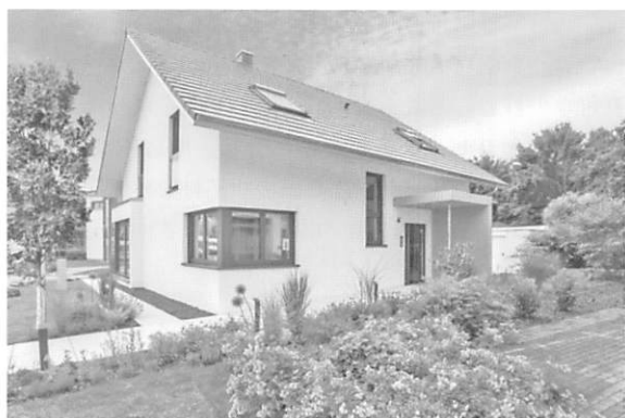
図14 中級クラスのプレハブ住宅外観
