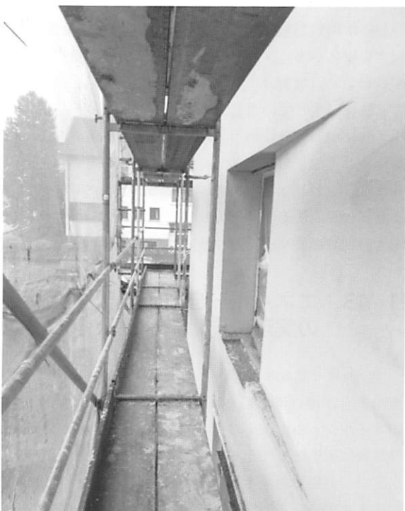
図4 教会外壁の湿式外断熱工事
