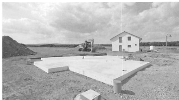
図11 プレハブ住宅基礎の断熱
