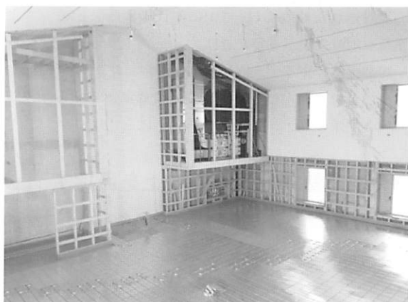
図3 教会内部の改修工事と床暖房工事
