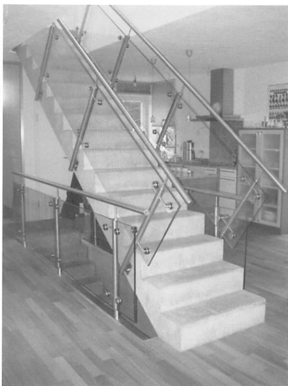
図10 コンクリート階段にガラス製手すり
