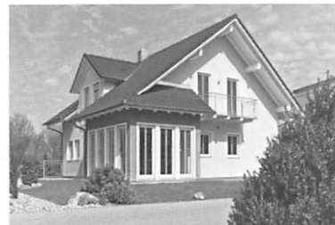
図 20 やや高級なプレハブ住宅外観(図 19 の木造プレハブ住宅木組みの完成後)
