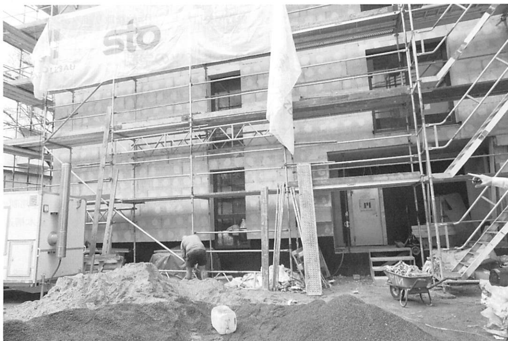
写真1 ベルリンの外断熱施工現場
