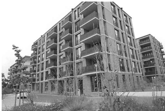
写真 13 外断熱が施された集合住宅
