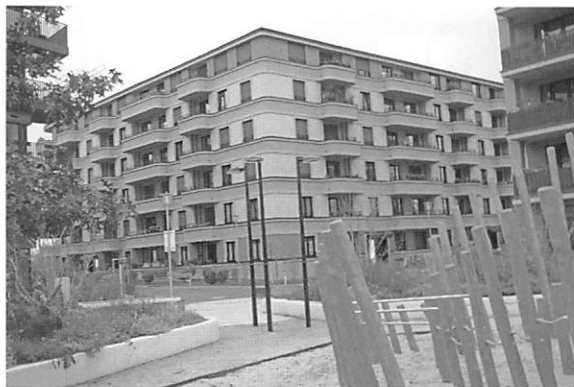
写真 14 外断熱が施された集合住宅
