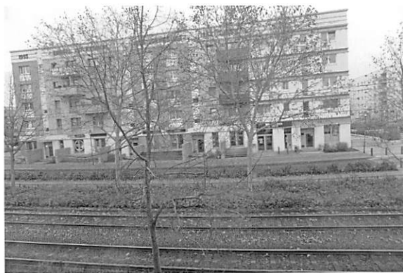
写真9 外断熱改修の行われた集合住宅
