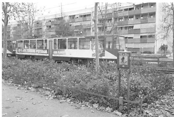
写真6 外断熱改修の行われた集合住宅
