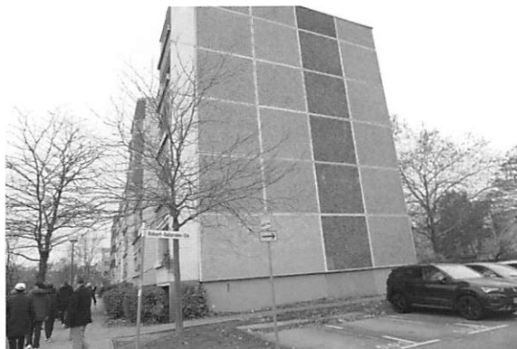
写真11 旧東独ではどの都市に行ってもプレキャストコンクリート集合住宅(ブラッテンbau; Plattenbau)が見られた。コンクリートにアスベストが含まれていたことからそれらの集合住宅は取り壊されたが、ここには残っていた。しかし旧東独時代の面影はなく、コンクリートには化粧が施されていた。
