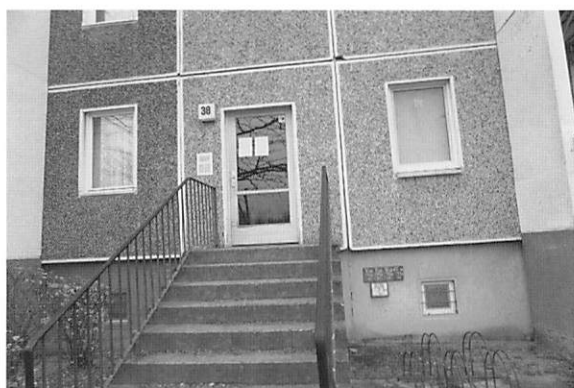
写真12 写真11と同じ集合住宅。降雪もあることから1階の入り口が地盤より高い場所に設けられている。
