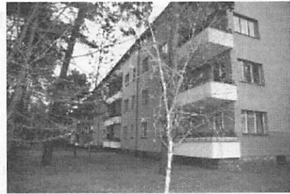
写真-3 アルゼンチン通りの集合住宅外観 (1927年建設) (Waldsiedlung Onkel Toms Hütte)
