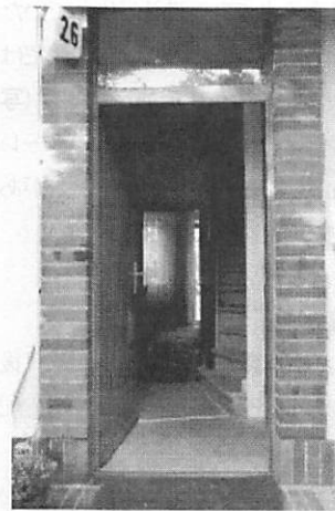
写真-6 庭側の扉との通風、および階段の煙突効果を利用した通風 (Waldsiedlung Onkel Toms Hütte)
