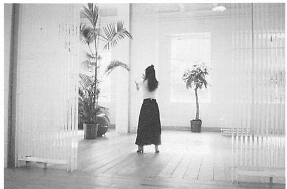
写真-20 夏の冷房に使用される放熱器
