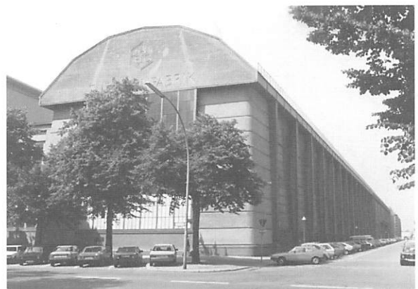
写真-1 AEGタービン工場 (Peter Behrens 設計 : 1909年)
