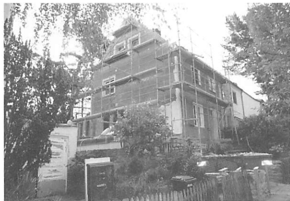
写真-26 タウトの設計した Onkel Toms Hütte の個人住宅の外断熱改修
