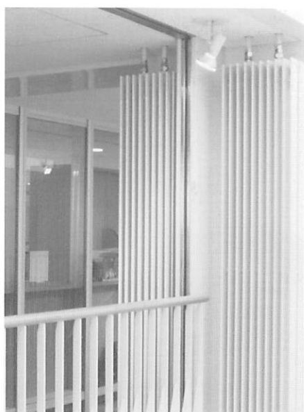
写真-21 放射による冷暖房（茨城県ふじ代の図書館：株式会社岡田新一設計事務所設計）
